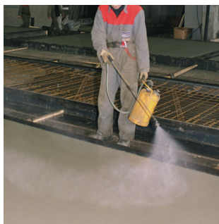
L'utilisation d'un produit de cure permet d'améliorer la qualité finale du béton.
